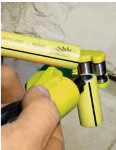
Corte con corta-tubo en obra.
