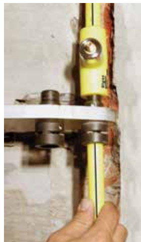
Thermofusión en la canaleta.
