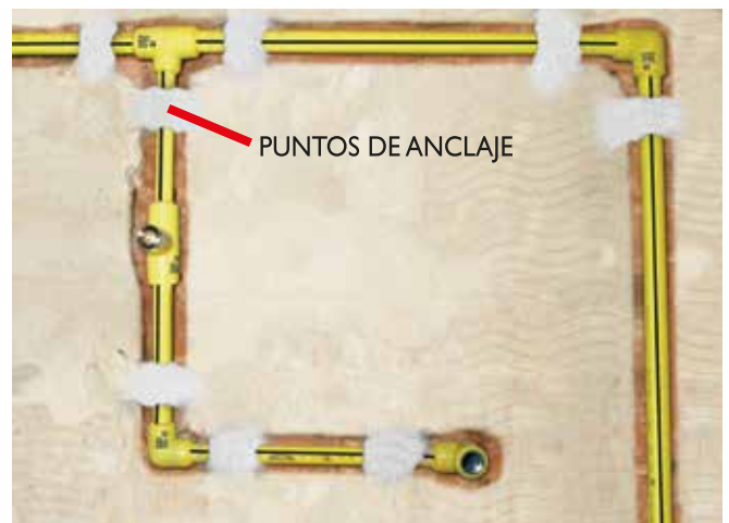
Vista parcial de instalación.
